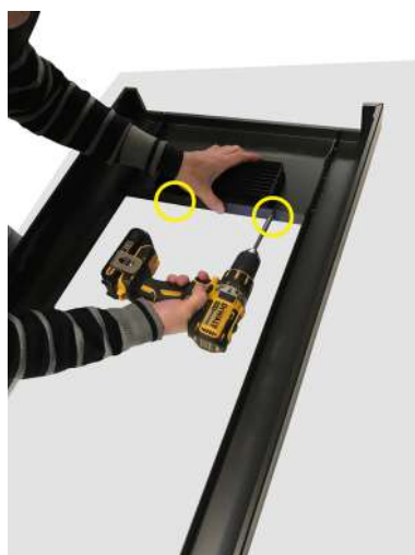
Fig. 23 - Fixação da grelha
