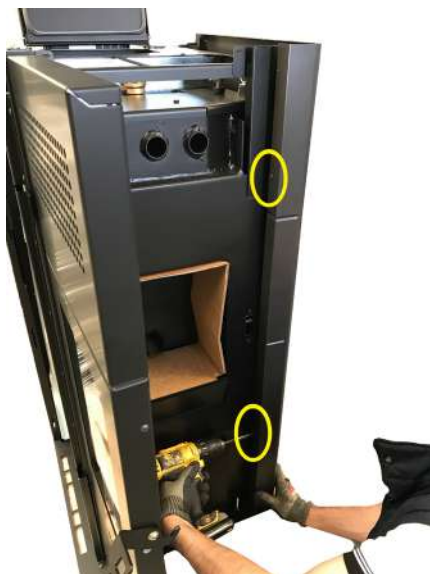
Fig. 36 - Fixação anterior traseira
