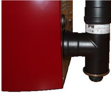
Fig. 37 - Limpeza do canal de fumo
