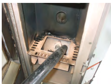
Fig. 31 - Limpeza do compartimento do braseiro
