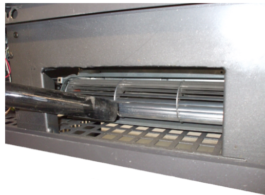
Fig. 42 - Limpeza do ventilador ambiente
