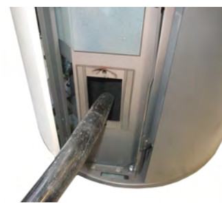
Fig. 57 - Limpeza canais
