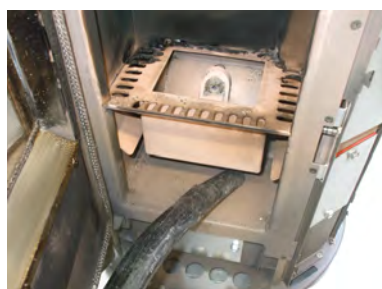
Fig. 32 - Limpeza do compartimento da gaveta de cinzas
