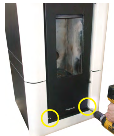
Fig. 20 - Fixação o painel frontal
